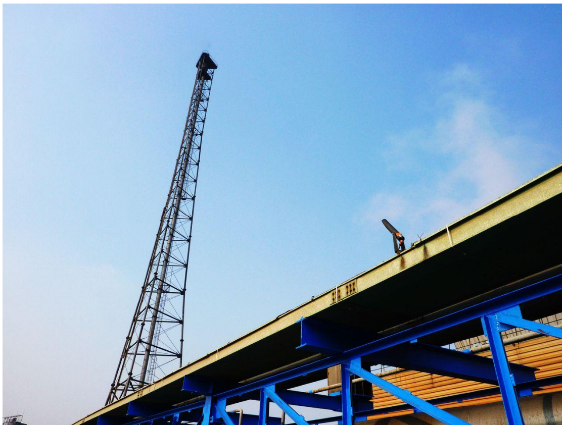
现场图片：火炬塔远程火焰检测
